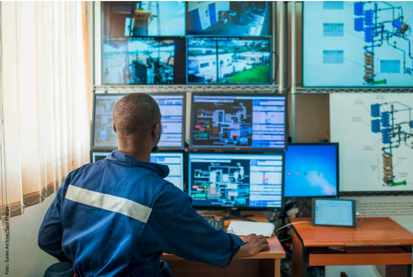
Un técnico controla el sistema automatizado que hace funcionar el Omni Processor de Janicki.
