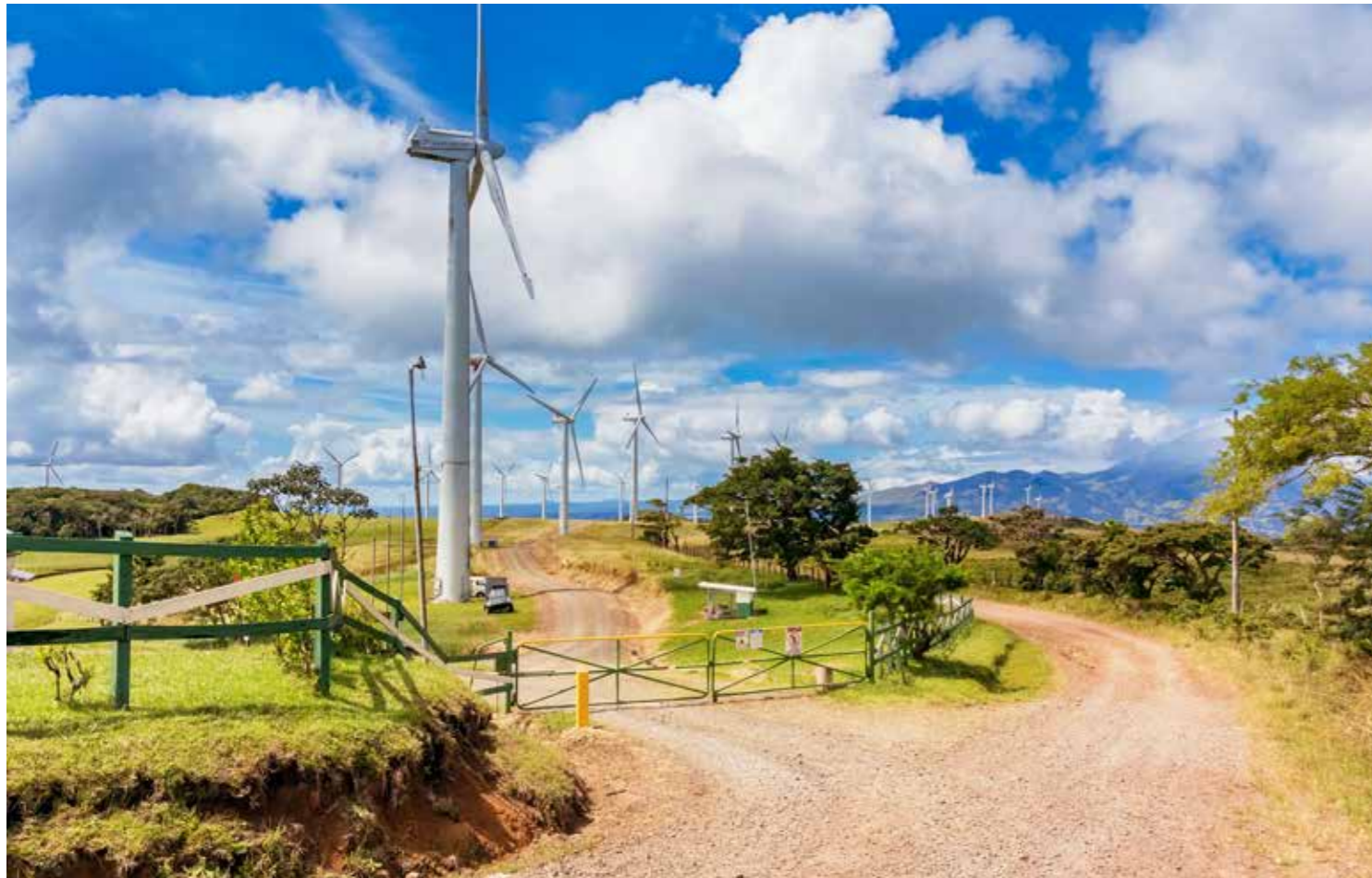
Las turbinas eólicas se extienden a lo largo de un camino polvoriento cerca de Tierras Morenas, Guanacaste.
